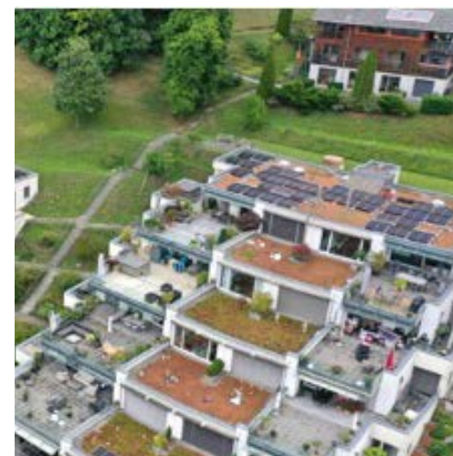
STWEG Höheweg 95 kWp
