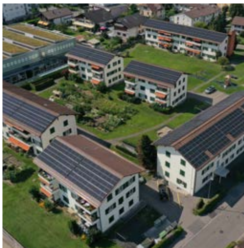
WBG Alpenblick 298 kWp
