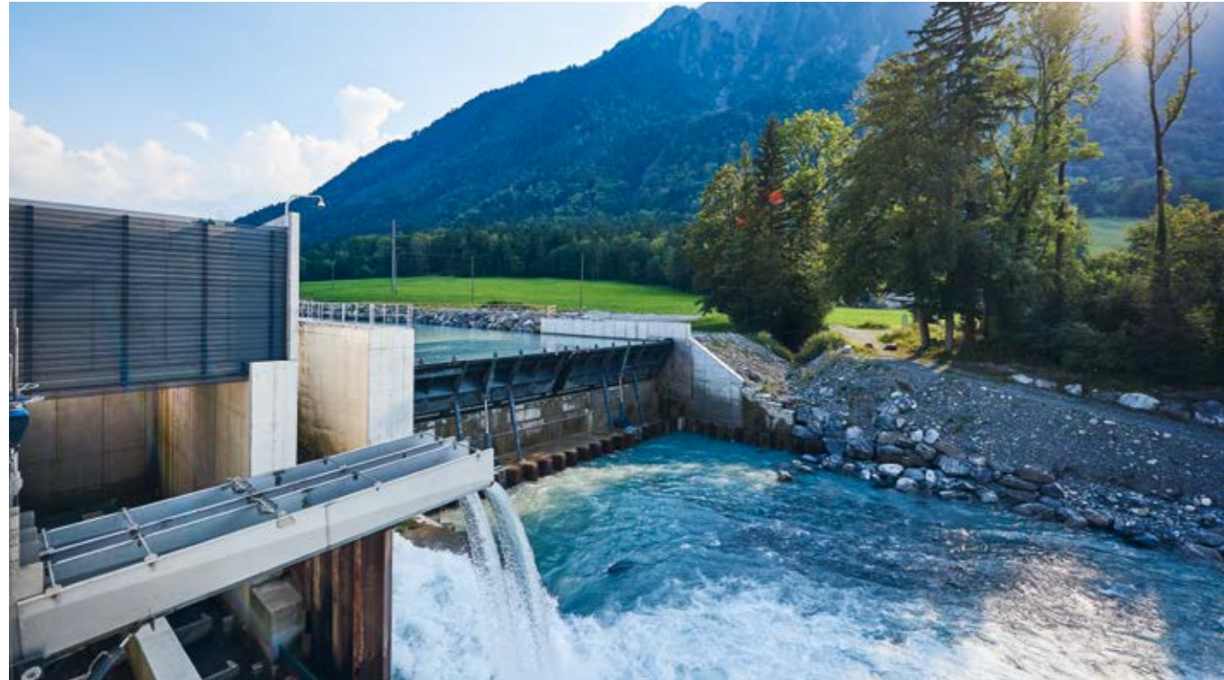
Aus Kanderwasser wird Strom für rund 7'700 Haushalte produziert.
