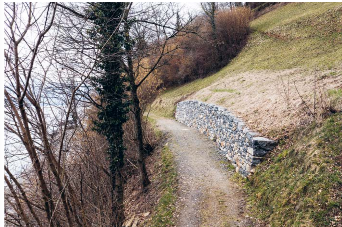
Die Trockenmauer reicht am Fuss 1.5 Meter weit in den Hang hinein.
