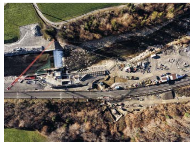
Für die geplante Aufweitung stehen noch einige Arbeiten an.
