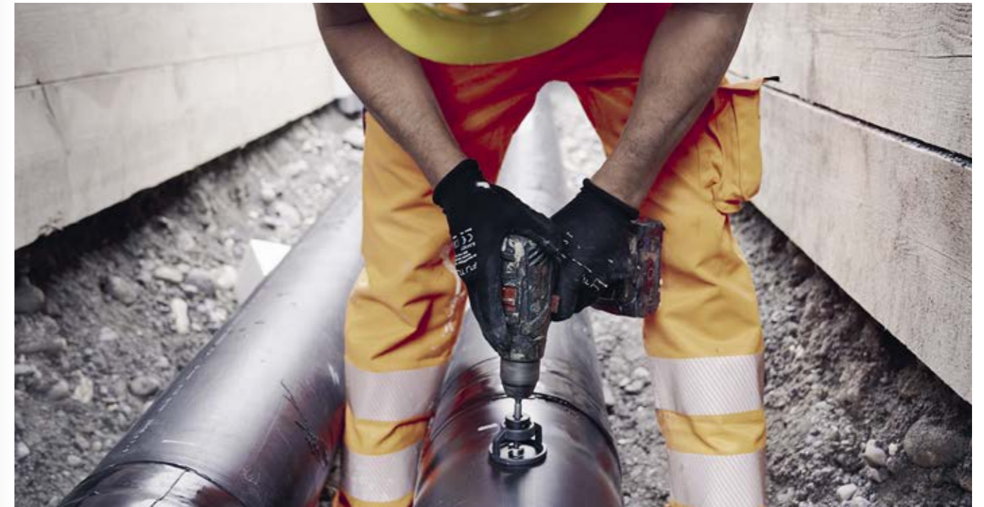
Schlussphase bei den Leitungen: Die Muffe wird dicht verschlossen.
