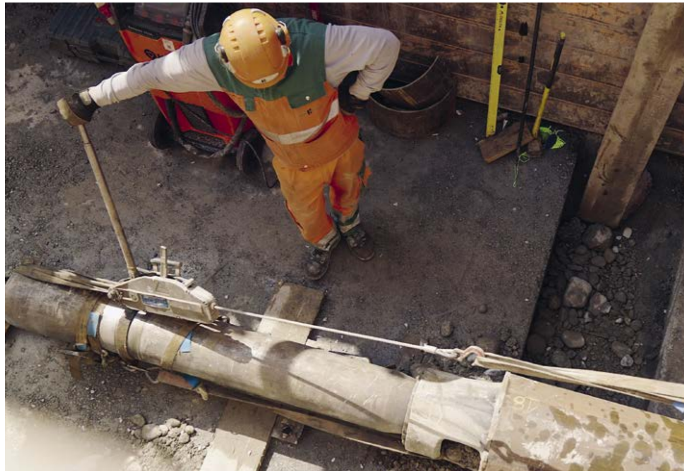
Geht's nicht mit offenem Graben, muss via Stahlrohre untertags der Weg für die Leitungen «freigepustet» werden.
