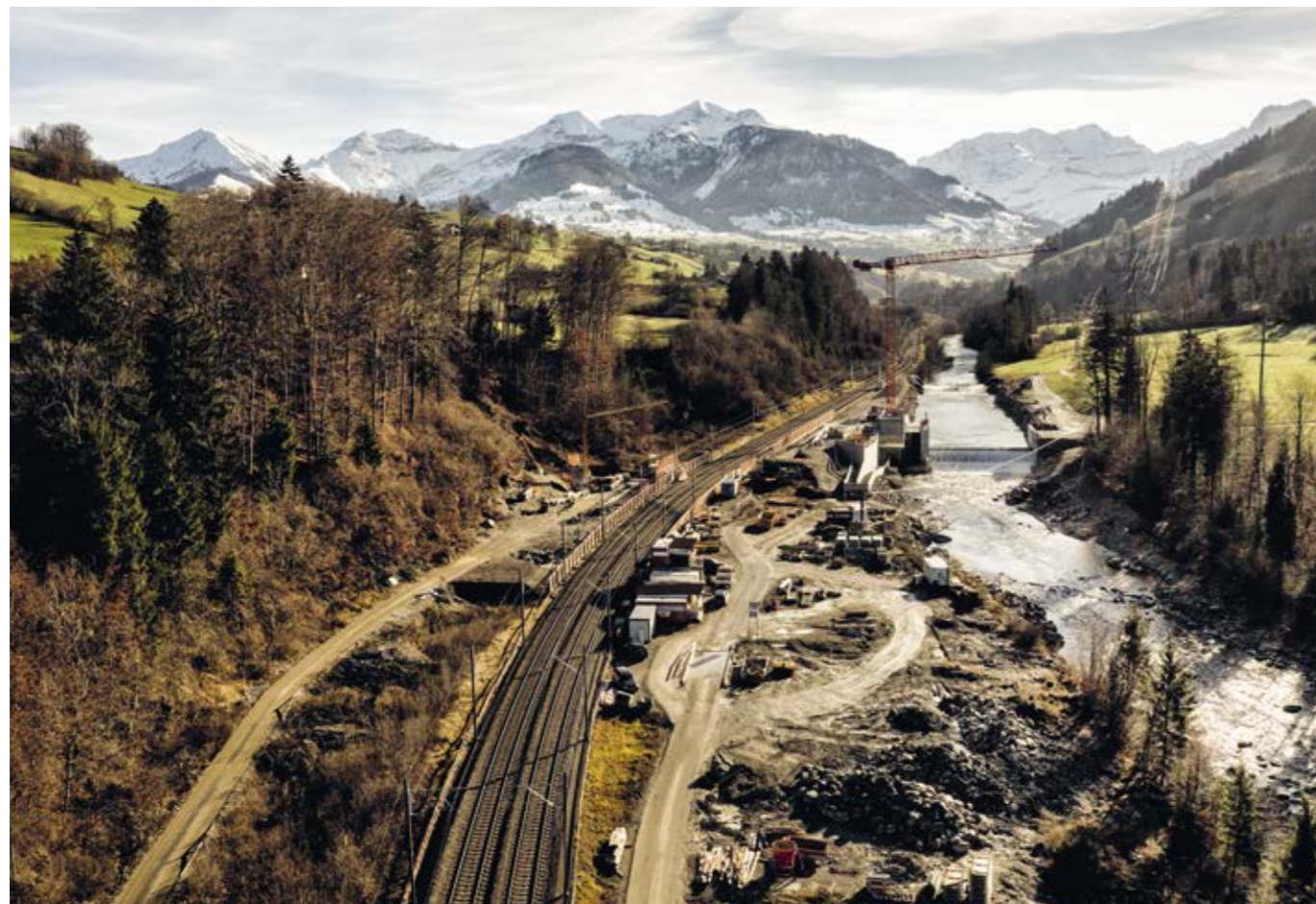
Im Baustellenbereich zwischen BLS und Kander werden nächsten Frühling die Aushubarbeiten für die Bühnen gemacht.
