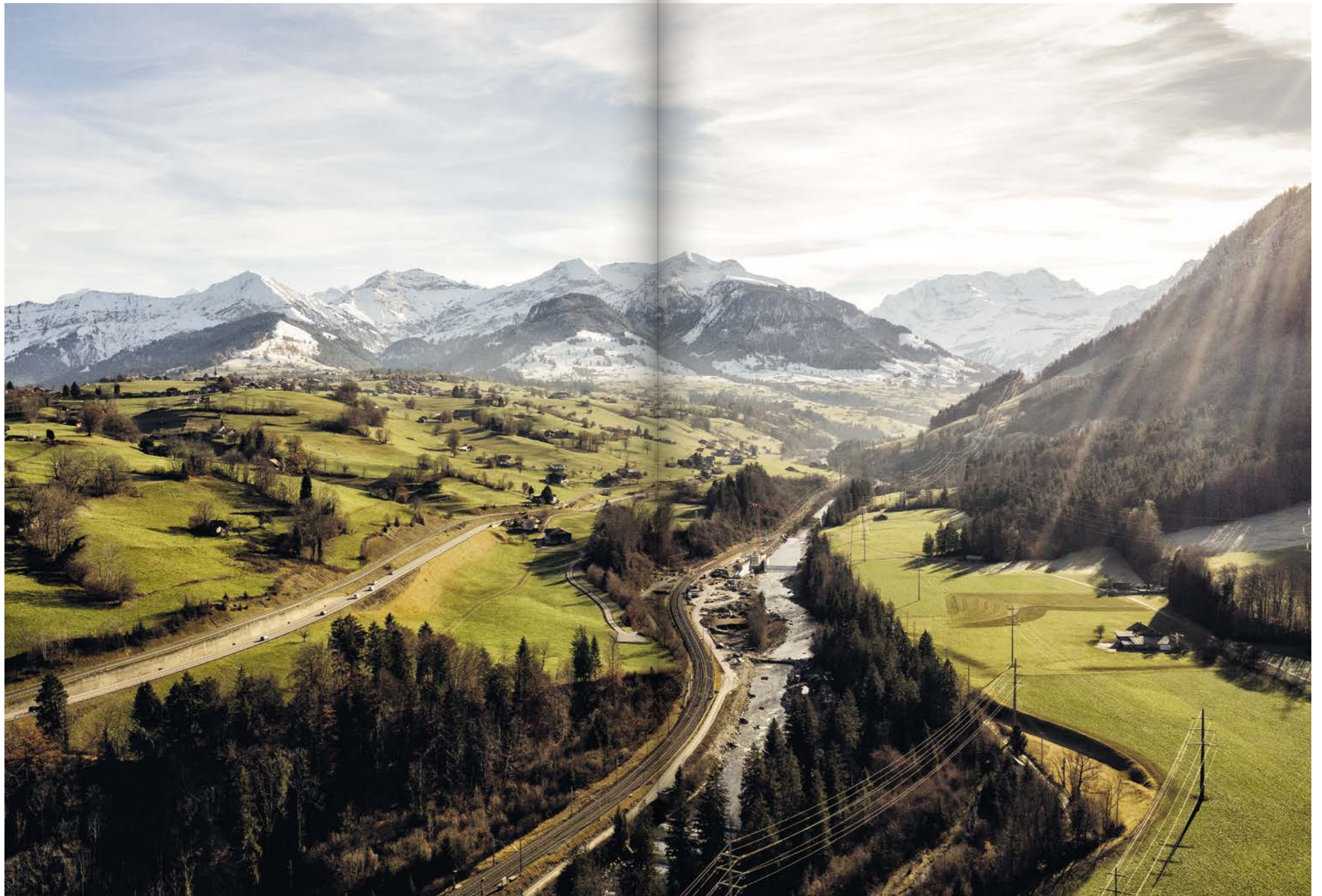
Die Kander im Bereich des neuen Wasserkraftwerks Augand. Näheres dazu auf Seiten 10 und 11.
