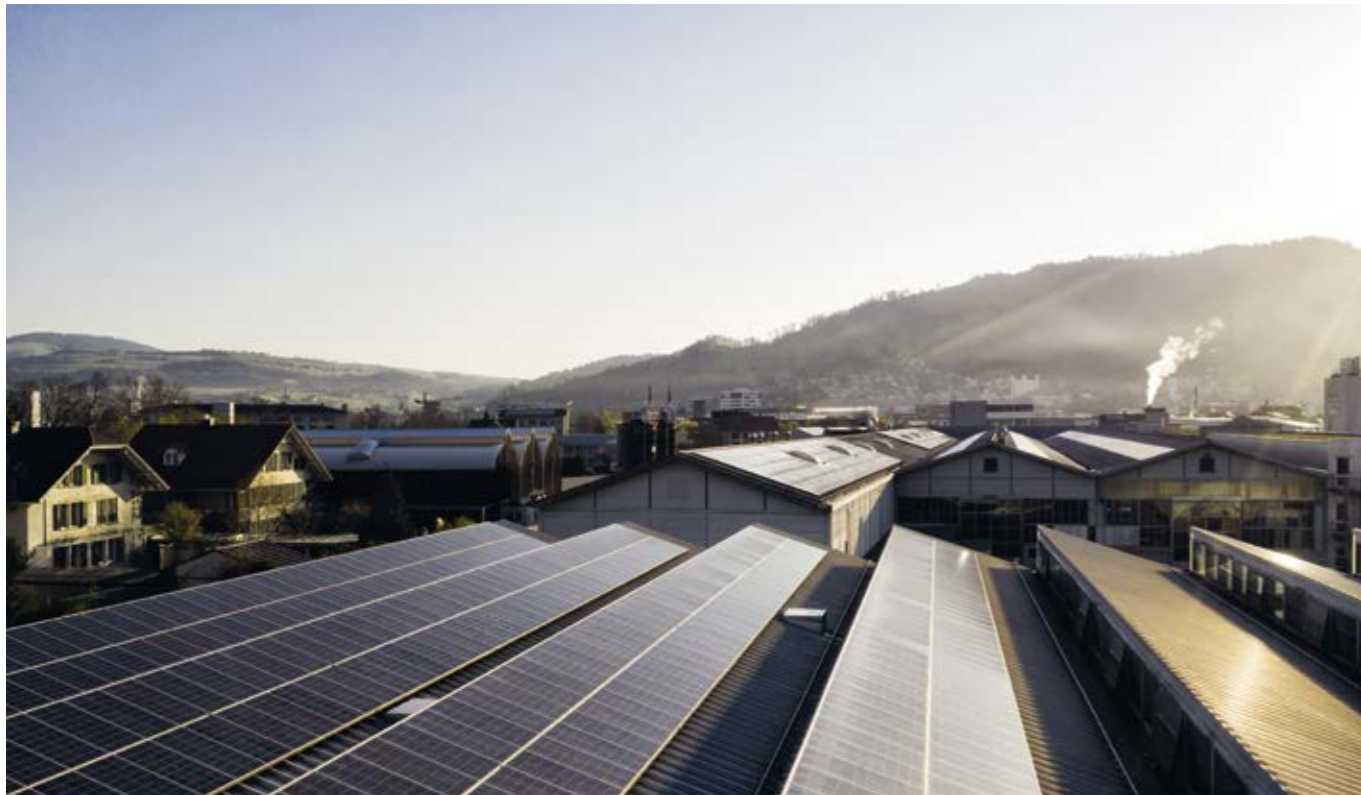
Etliche Dächer und Fassaden sind für PV-Anlagen geeignet.
