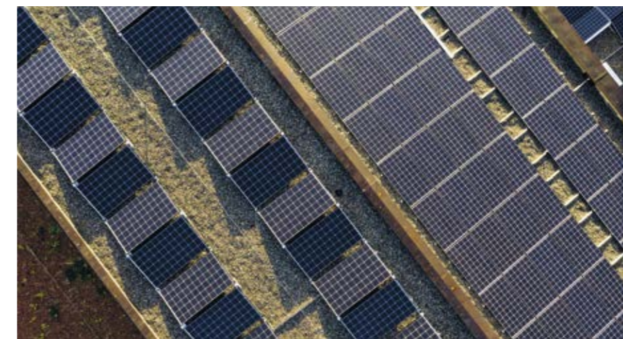
Dächer, die für eine Photovoltaikanlage geeignet sind, gibt's in Thun und Umgebung viele ...
