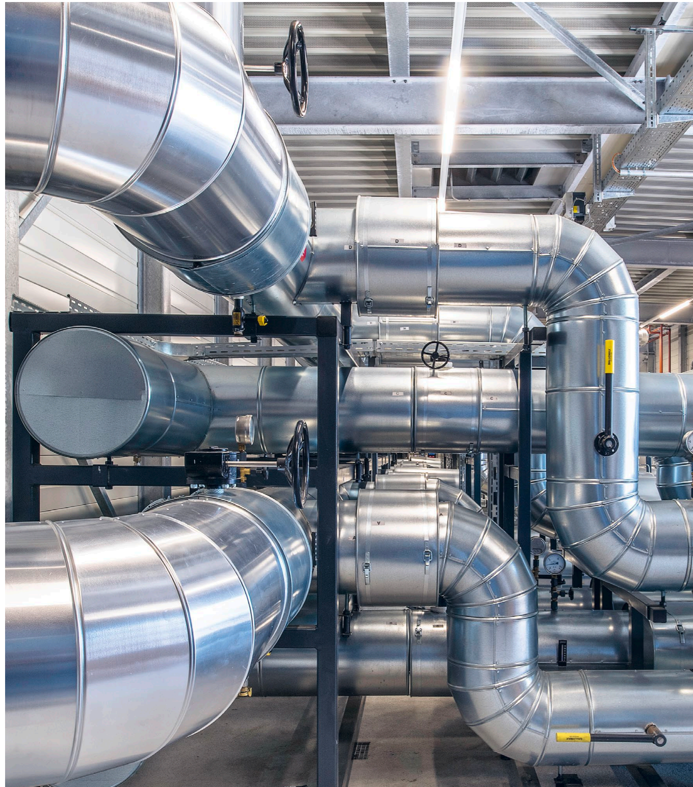
Start der Fernwärmeleitungen in der AVAG Thun.
